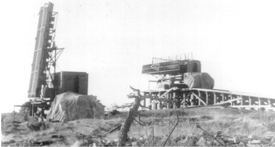
För att få spaningsstationen högre upp byggdes en fast underdel i trä. (Foto från boken kontroll- och varningssystemets historie)
