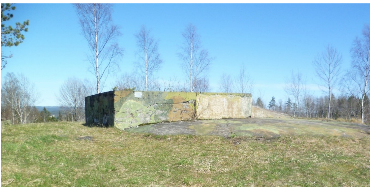
Trolig plats för AMES stn i Trögstad fort (fundamentet troligen tillkommit därefter för annan station). (Foto FHT)
