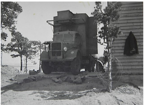
Observationsrum till AMES 14 (och AMES 13)
